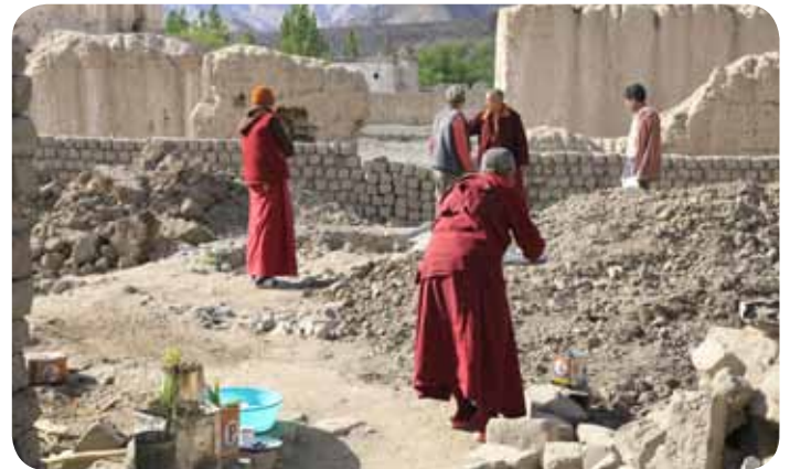
Bouw van het klooster op historische plek in Nyerma
